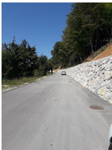
Cesta Dvor – Mačkovec je delno urejena z opornim zidom.
