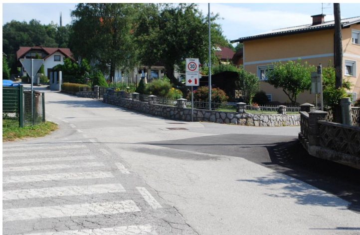
Ozka cesta (v bližini vrtca), brez pločnika. Nepregledno, prometno križišče. Sedaj so na cesti postavljene tri grbine. V zimskem obdobju jih odstranijo.
