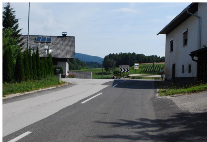
Nevaren, nepregleden ovinek (pri Grčarjevih). Cesta brez pločnika in prehoda za pešce.
