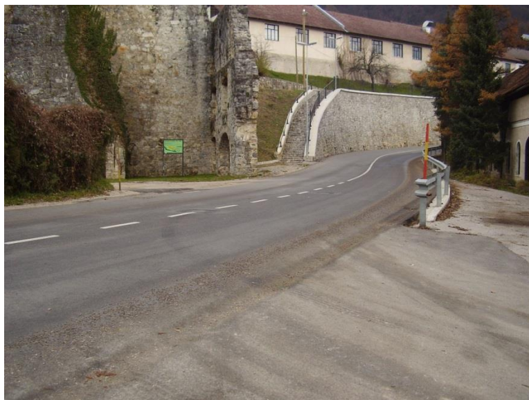
Nevarni del ceste od križišča na Dvoru proti mostu.
